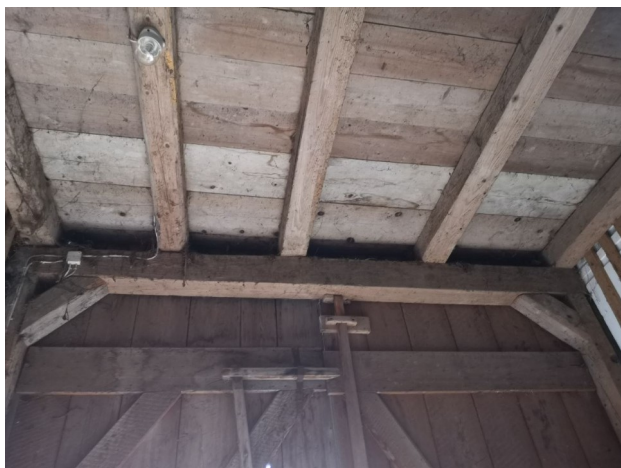
Abb. 9: Dachstuhl der Scheune
